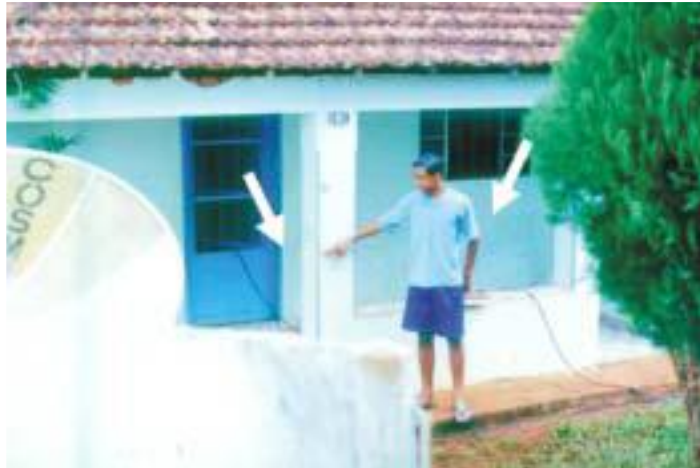
Figura 1 -Residência com indicativos de alagamento em 2002.
