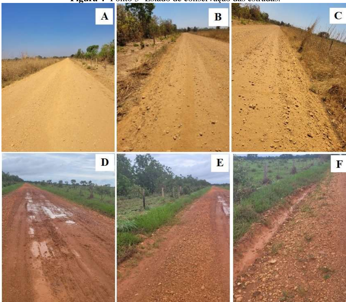
Figura 4- Ponto 3- Estado de conservação das estradas.
