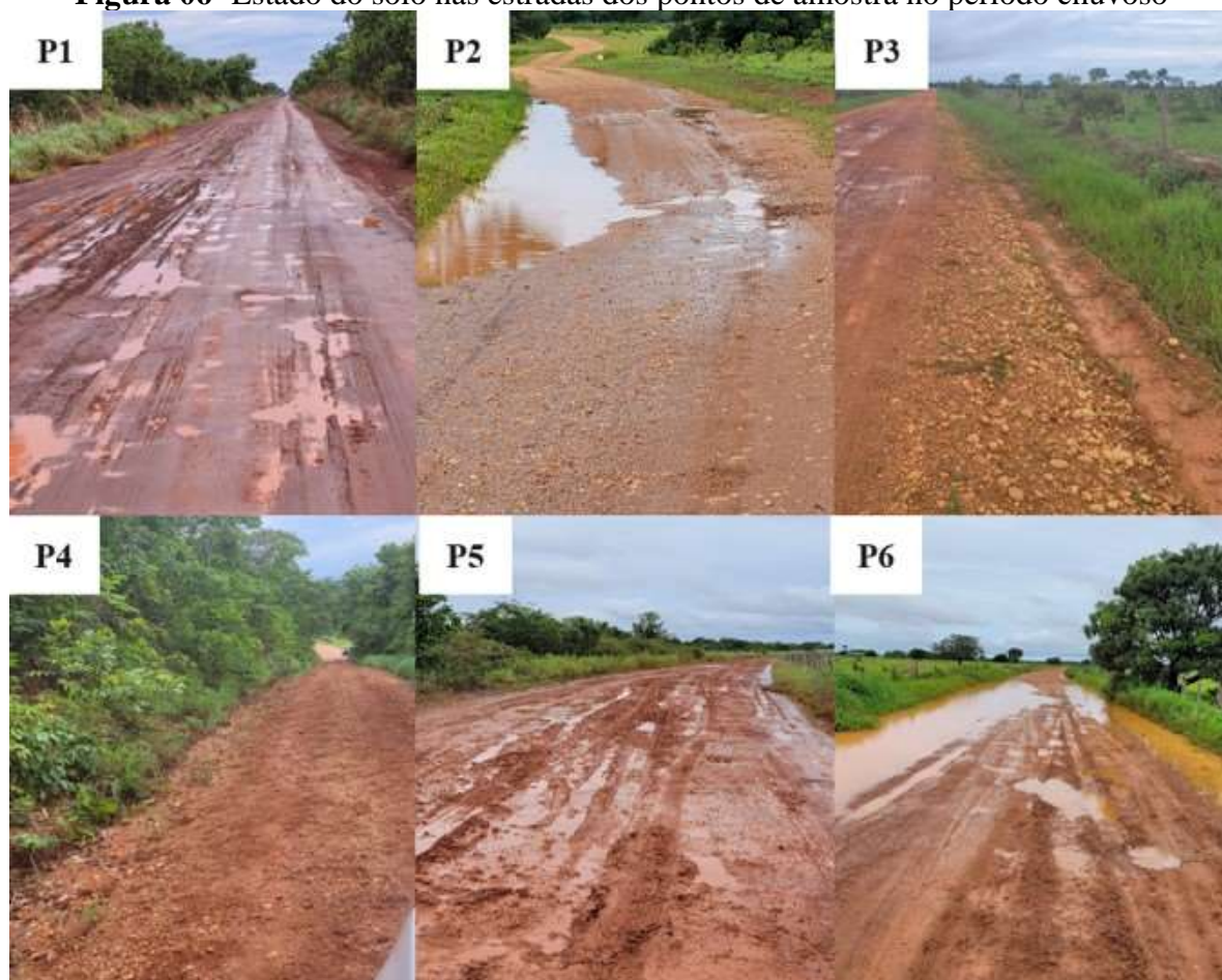
Figura 06- Estado do solo nas estradas dos pontos de amostra no período chuvoso
