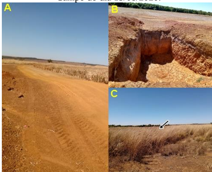
Figura 35- Estado de conservação das estradas do ponto 6. Campo do dia 15/08/2020:
