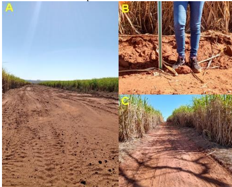
Figura 17- Estado de conservação das estradas do ponto 3. Campo do dia 15/08/2020:
