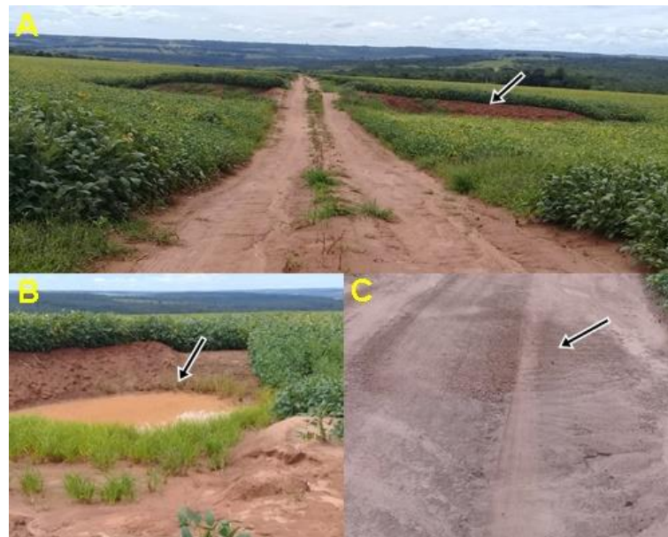
Figura 20- Estado de conservação das estradas do ponto 4. Campo do dia 13/02/2020
