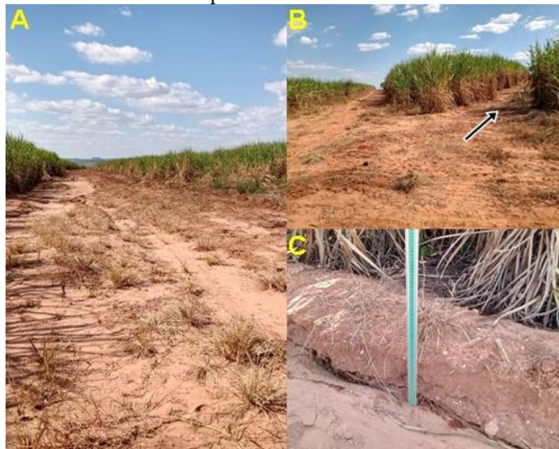
Figura 16- Estado de conservação das estradas do ponto 3. Campo do dia 14/06/2020:
