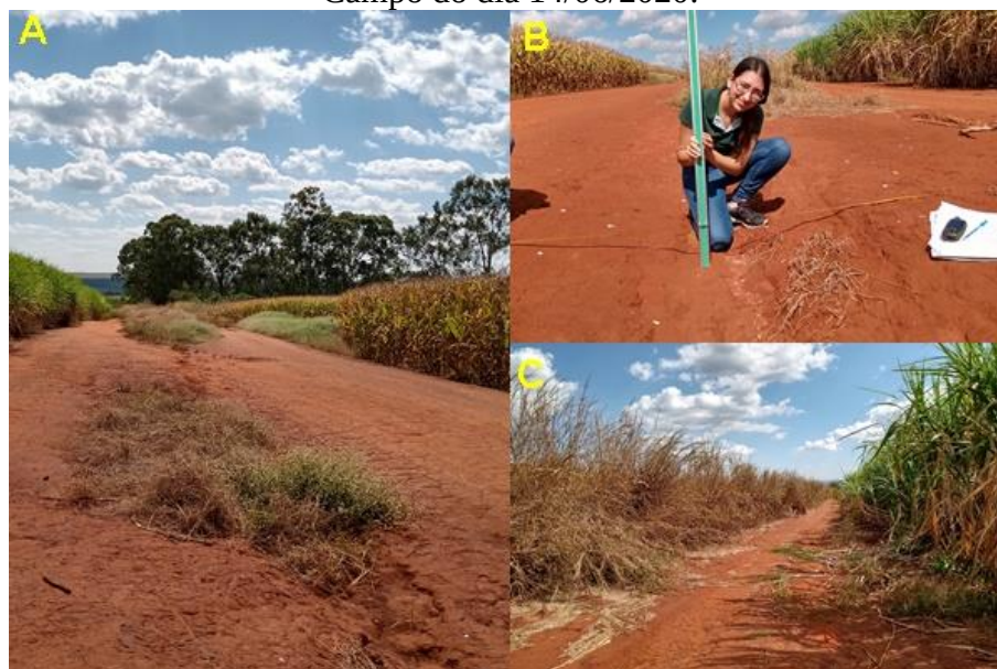
Figura 4- Estado de conservação das estradas do ponto 1. Campo do dia 14/06/2020:
