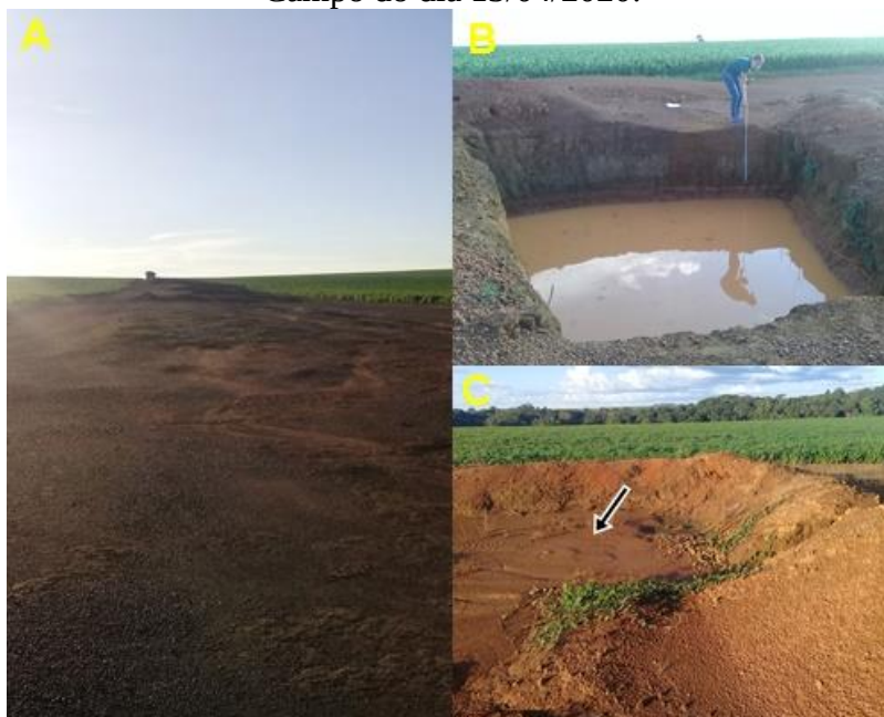
Figura 33- Estado de conservação das estradas do ponto 6. Campo do dia 13/04/2020:
