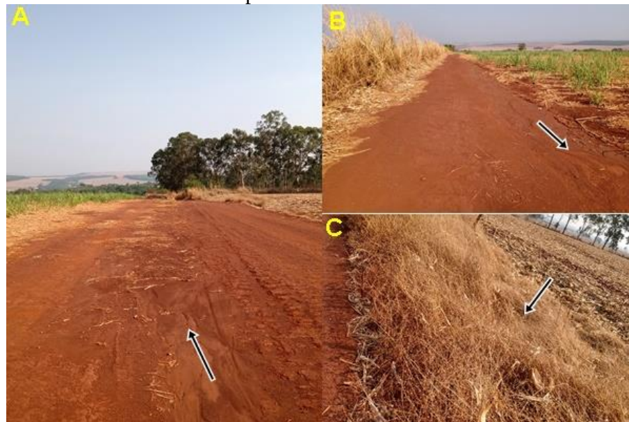
Figura 6- Estado de conservação das estradas do ponto 1. Campo do dia 14/10/2020:
