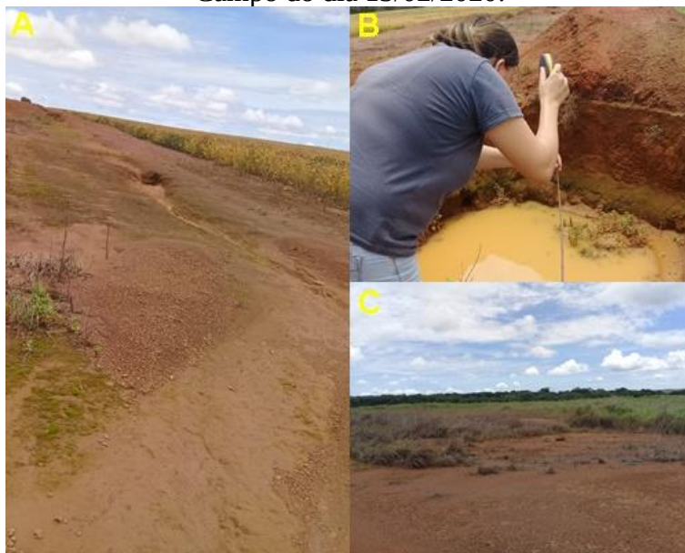
Figura 32- Estado de conservação das estradas do ponto 6. Campo do dia 13/02/2020:
