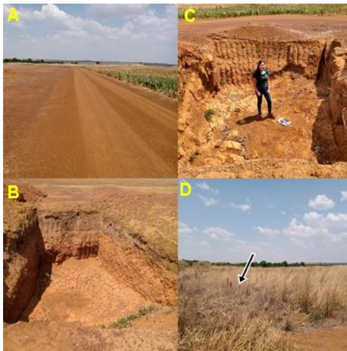
Figura 36- Estado de conservação das estradas do ponto 6. Campo do dia 14/10/2020:
