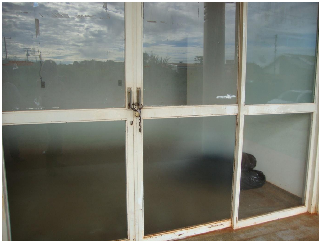
Figura 45: Sala reservada à disposição de resíduos de serviços de saúde para coleta, em posto de saúde em Rio Verde – (GO)
