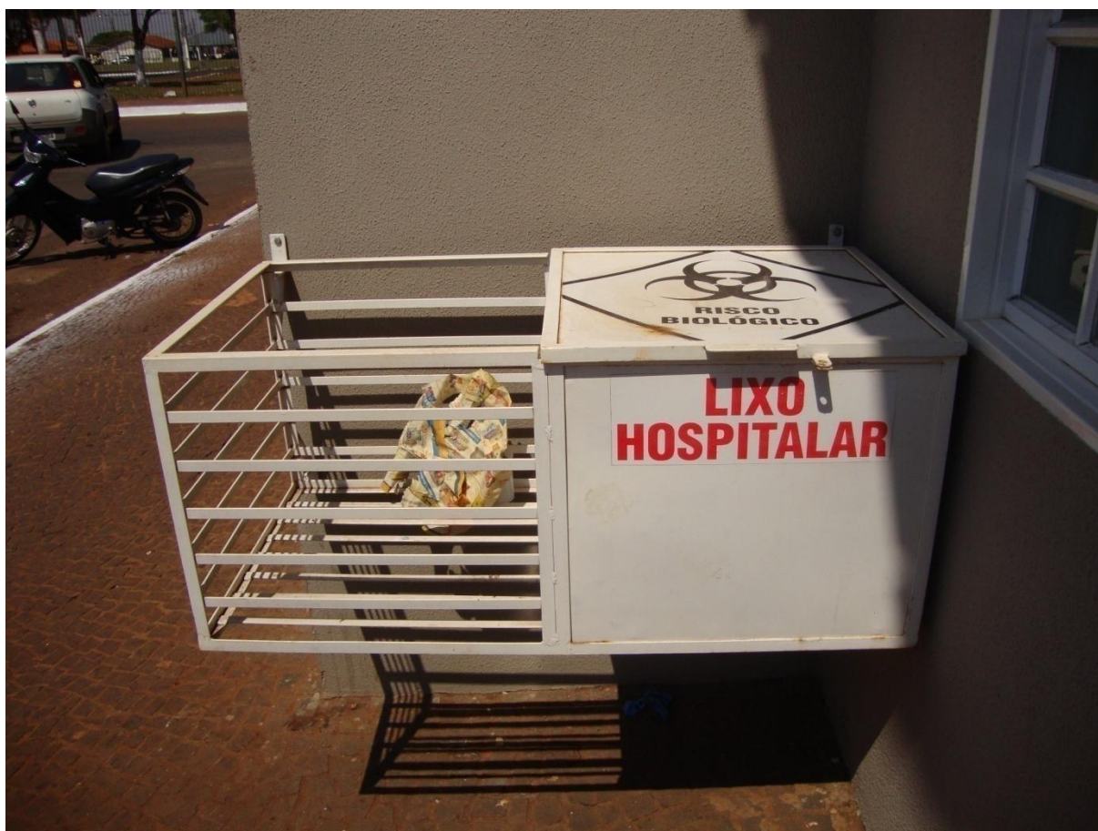
Figura 22: Caixa de armazenamento externo de resíduos de serviços de saúde
