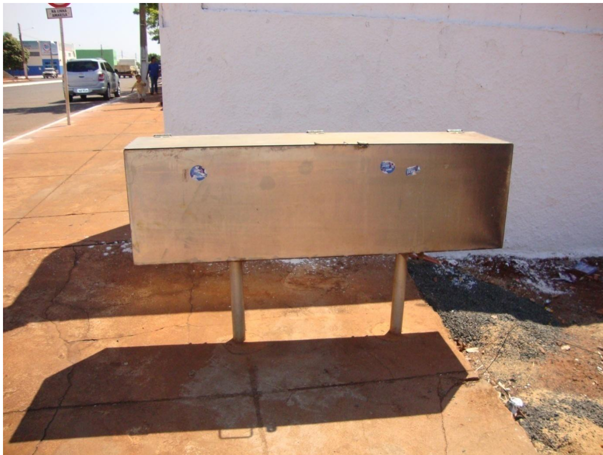
Figura 19: Caixa de armazenamento externo de resíduos de serviços de saúde do IML – Rio Verde
