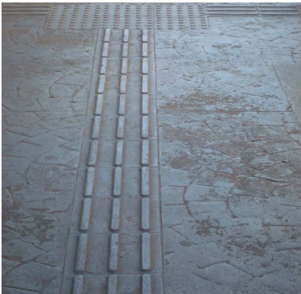
Foto 48 – Calçada com faixa tátil em conformidade com a NBR 9050
