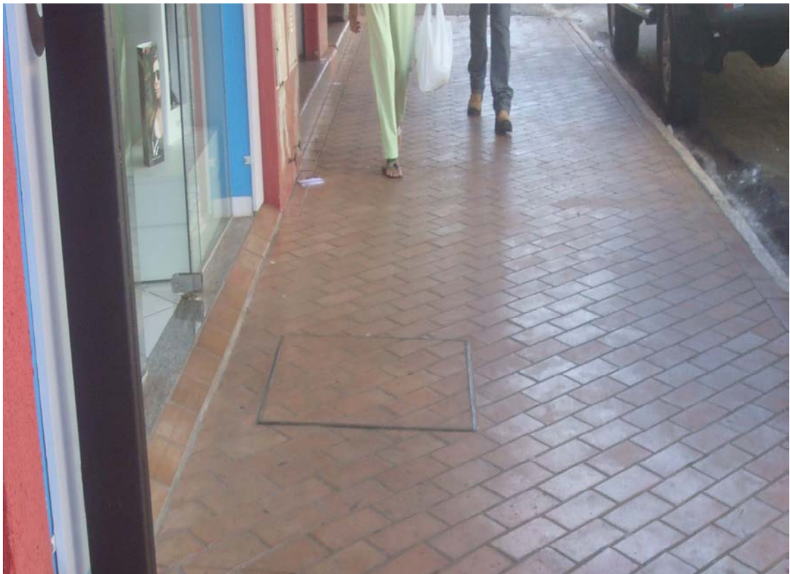
Foto 39 – Calçada com material da superfície em conformidade com a NBR 9050
