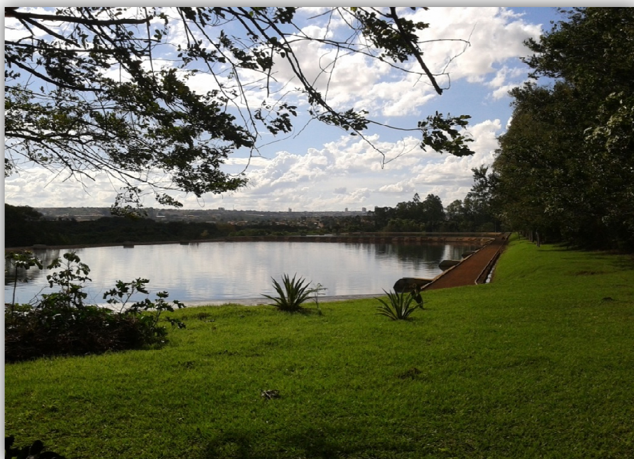
Figura 10 : Estação de Tratamento de Esgotos (ETE) da cidade de Jataí (GO) Fonte: Arquivo do autor
