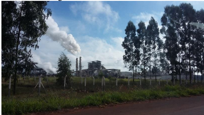
Foto 7 - Ponto 65 - Usina Raízen Energia S/A. Jataí – Goiás.
